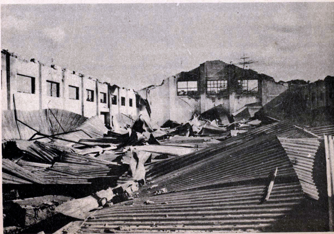
36. - . Dezelfde textielfabriek (ouder gedeelte met houten kap constructie).
